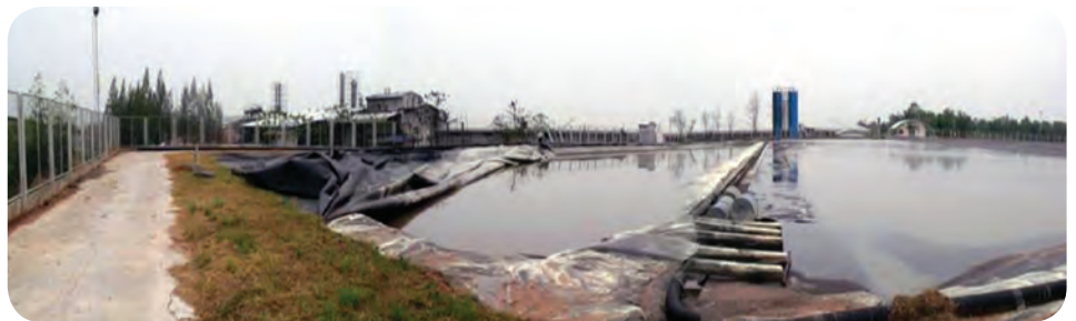
ภาพที่ 55 สภาพปกติของบ่อผลิตและเก็บก๊าซชีวภาพที่ปิดคลุมด้วยผ้าใบ HDPE และสภาพบ่อหลังจากผ้าใบแตกขาด
