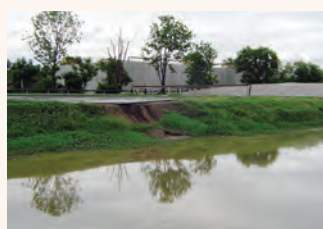
บ่อเปิดเพื่อบำบัดน้ำเสียชั้นหลัง
