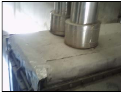
รูปที่ 5.18 การหุ้มฉนวนที่บริเวณด้านบนของแผงแลกเปลี่ยนความร้อน
