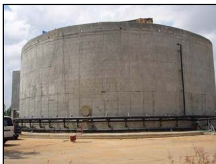
รูปที่ 4.32 ถังผลิตก๊าซมีเทนของระบบยูเอเอสบี
