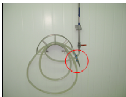
รูปที่ 5.8 การใช้ท่อปลายบีบที่มีวาล์วเปิด-ปิดน้ำ
