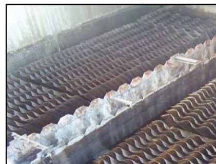
รูปที่ 4.32 ถังผลิตก๊าซมีเทนของระบบยูเอเอสบี
