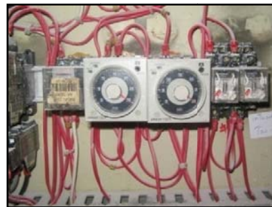
รูปที่ 6-1 การติดตั้งอุปกรณ์ทำความสะอาดตะแกรงอัตโนมัติ
