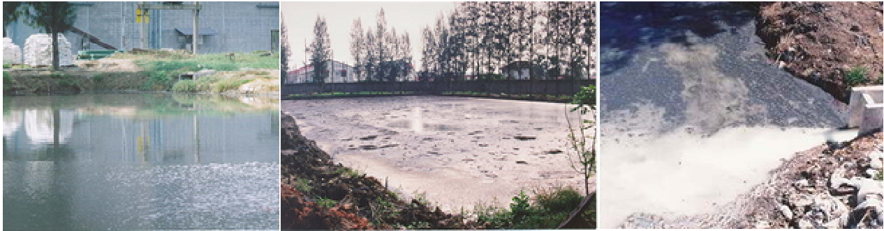
รูปที่ 4.30 ระบบบำบัดแบบบ่อเปิด
