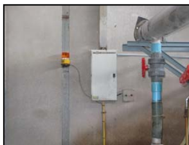
รูปที่ 6-4 การติดตั้งอุปกรณ์แจ้งเตือนการล้นของน้ำแอมโมเนีย (ไฟไซเรนสีส้ม)
